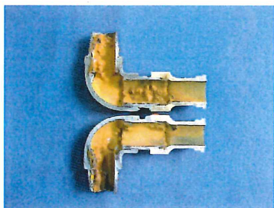
写真-7 配管の劣化調査
