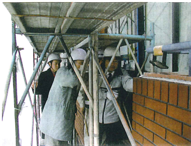
写真－4 工事監理
