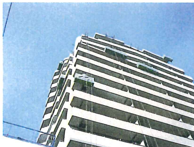
写真-6 ゴンドラによる作業
