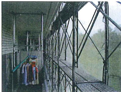
写真-5 工事中の状況
