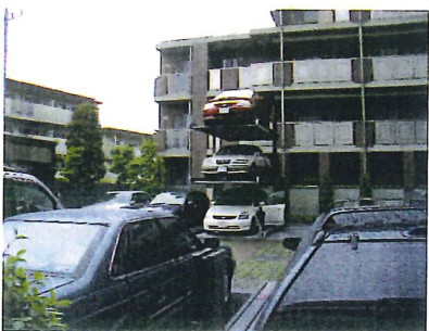
写真-9 機械式駐車場
