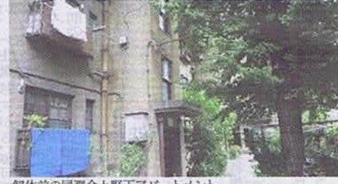
解体前の同潤会上野下アパートメント
